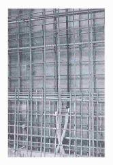
Bild 5. Arbeitsfuge Wand-Bodenplatte und eingezogene vertikale Wandvorspannung
