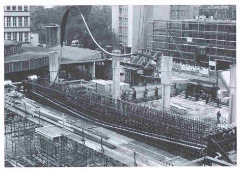
Bild 4. Versetzarbeiten der BBRV 8320 kN-Kabel
