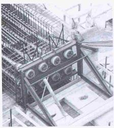
Bild 3. Verankerungsbereich mit Stahlkonstruktion zur Fixierung der Ankerplatten
