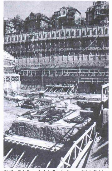
Bild 2. Tiefe Baugrube beim Bau des Frauenspitals in Zürich
