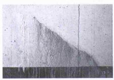
Bild 3. Aussinterungen bei einem wasserführenden Trennriss
