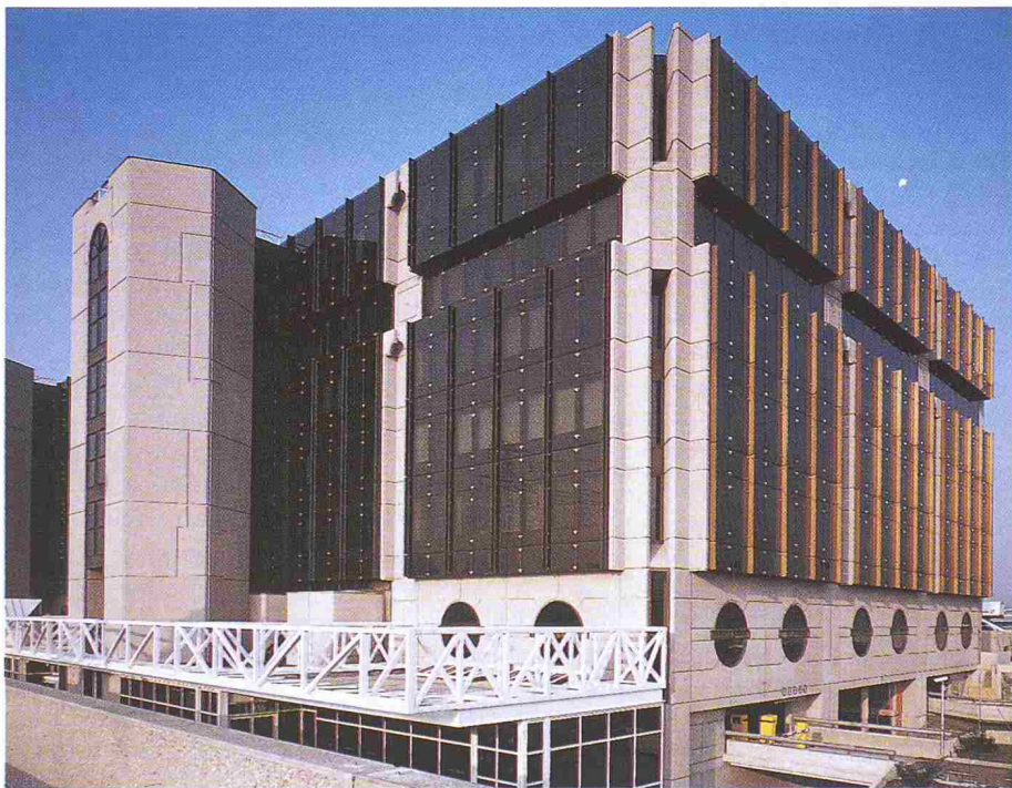
Eine der Hauptansichten des Gebäudes mit den Eingangsanlagen und dem Treppenhaus der IATA. Die Pfosten-Riegelkonstruktion mit der nach aussen zu öffnenden vorgängigen Glasschürze gibt dieser Kalt-Fassade alle Vorteile bei der Beurteilung der bauphysikalischen Eigenschaften
