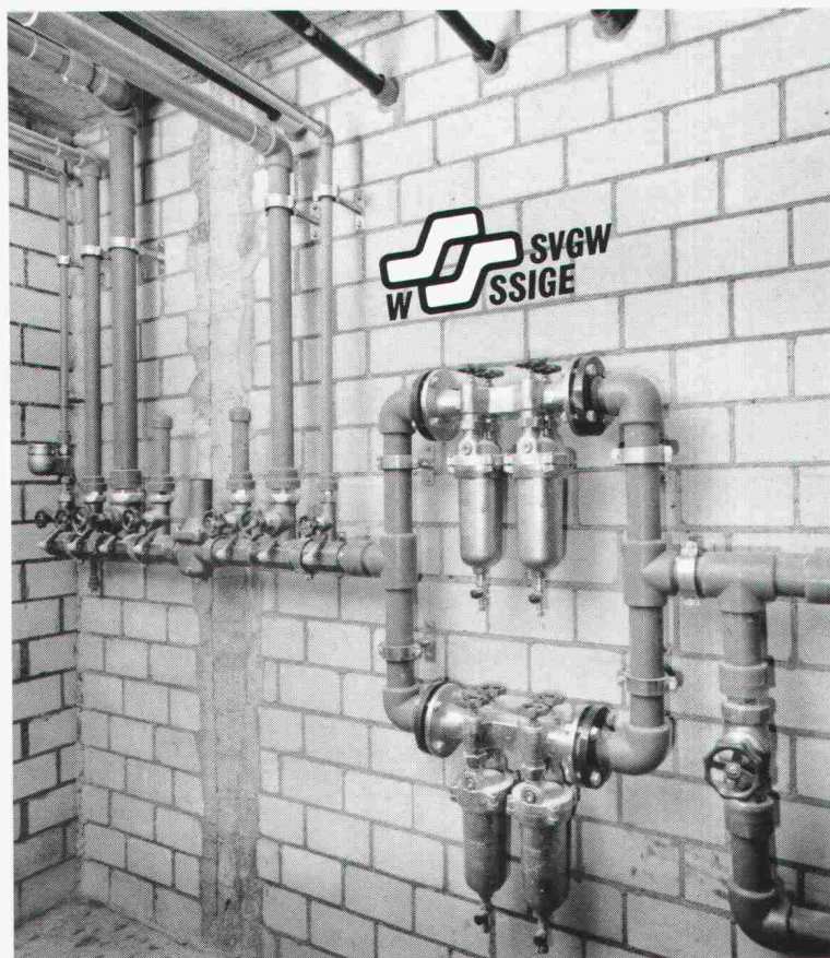
Verteilerbatterie in der Mövenpick-Raststätte «Heidiland» bei Sargans
