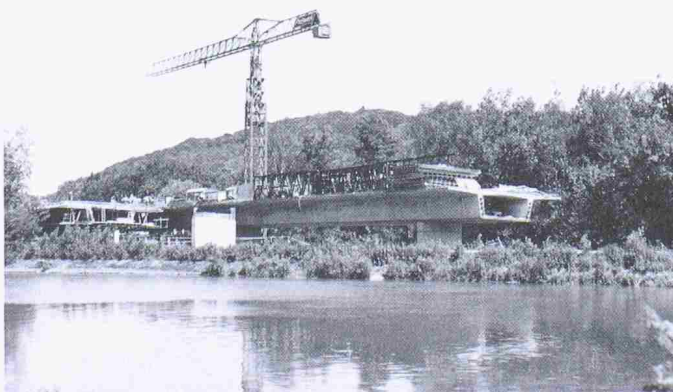
Bild 10. Überbau zwischen Aarealtlauf und Oberwasserkanal
