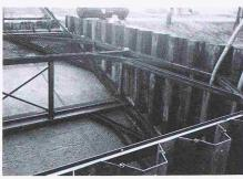
Bild 9. Oberwasserkanal im Bereich des Pfeilers 3 Nord mittels speziellem Fangdamm trockengelegt. Deutlich sind die Betonplatten der Kanalauskleidung ersichtlich
