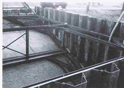
Bild 9. Oberwasserkanal im Bereich des Pfeilers 3 Nord mittels speziellem Fangdamm trockengelegt. Deutlich sind die Betonplatten der Kanalauskleidung ersichtlich
