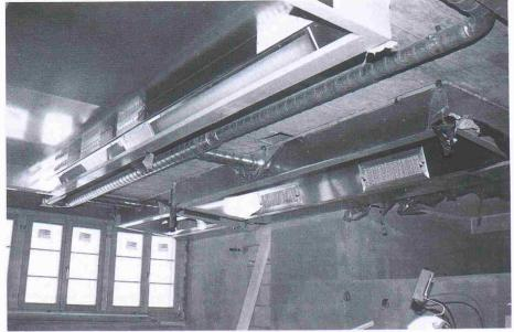
Bild 3. Ablufthauben Restaurant «Heimat», Bauma: Blick auf die Blasdüsen (vordere Haube) bzw. auf die Fettfilter (hintere Haube). Zwischen den Hauben verläuft die Blasluftleitung
