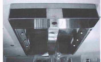
Bild 6, links. Rauchprobe. Im Bereich der Luftströmung wird der schwebende Rauch durch den Blasluftstrahl mitgerissen und nicht mehr sichtbar
