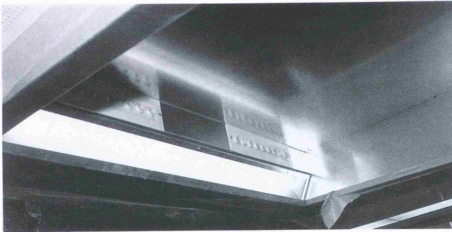
Bild 4. Blasluftkanal mit Blasdüsen (davon einige verschlossen) und Beleuchtung. Die Blasdüsen erscheinen infolge Spiegelung an der Haubendecke doppelt
