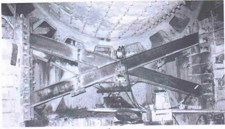
Bild 15. Ausgeführte Fundamentversteifung
