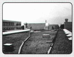
Absaugen von Kies, Sand und Humus ab Flachdach, bei Baustellen und Kellern mit erschwertem Zugang.
