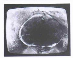
Vertikale Deformation des Kanalrohres
