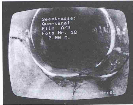
Rohrbruch in der Sohle
