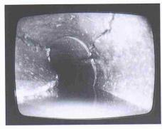
Seitliche Deformierung des Kanalrohres
