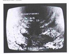
Korrosion der Kanalsohle
