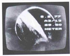
Wassereinbruch bei Rohrmuffe
