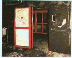
Brandfall im Donaucenter Wien.Lt. Löschbericht der Wiener Feuerwehr dauerte der Brand 23/4 Stunden, wobei Spitzentemperaturen von 1400 C erreicht wurden. Ing. Carl Novak stellt fest, dass die Türen-/Rahmenkonstruktion funktionsfähig geblieben sind und nicht ersetzt werden mussten.
