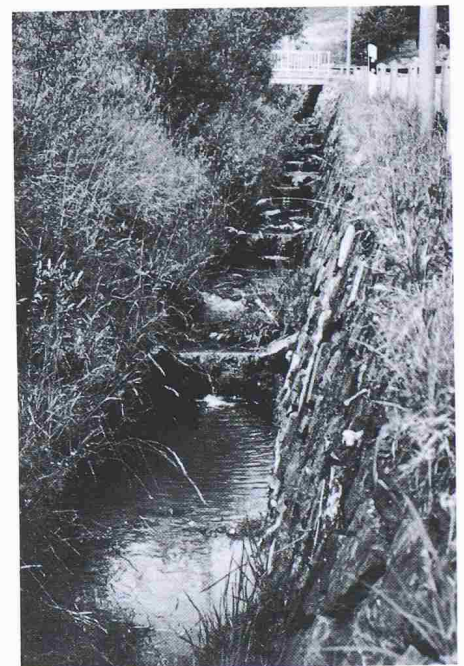
Bild 5. Folge von Fischbecken bei grossem Gefälle (Weiherbach Wila)
