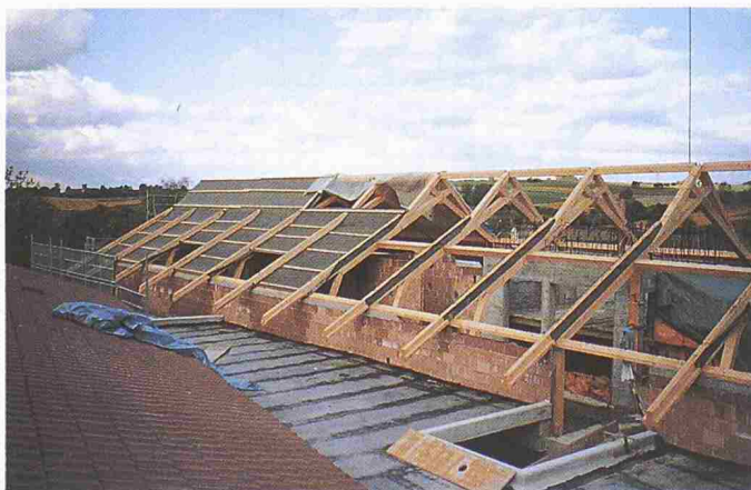
Bild 6. Ansicht der fertig aufgerichteten Binder
