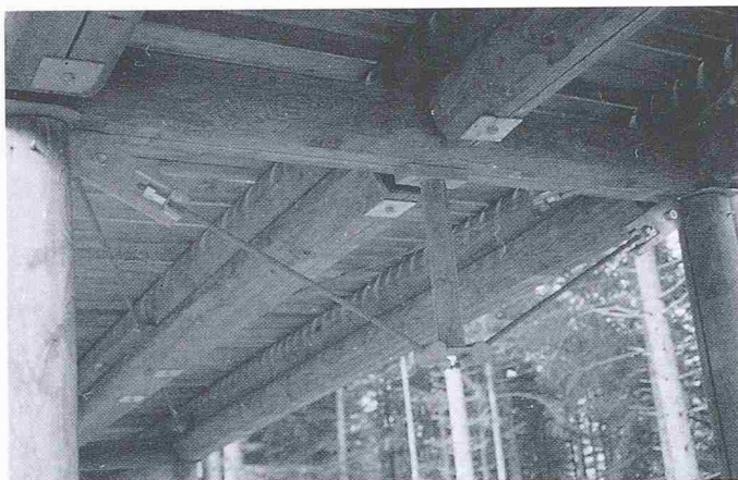
Bild 27. Anschluss der Längstragelemente an den unterspannten Querträger (im Bereich Zugangsrampe)
