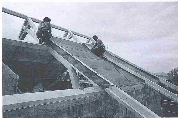
Bild 9. Verlegungen und Verschweissen der Dampfsperre
