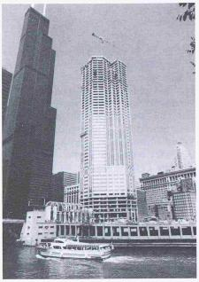
Links der Welt höchstes Gebäude in Stahlskelett-Bauweise, der 443 m hohe Sears-Tower in Chicago, daneben das welthöchste Gebäude in Stahlbeton, das «311 South Wacker Building» während des Baues bei etwa 240 m Höhe.
