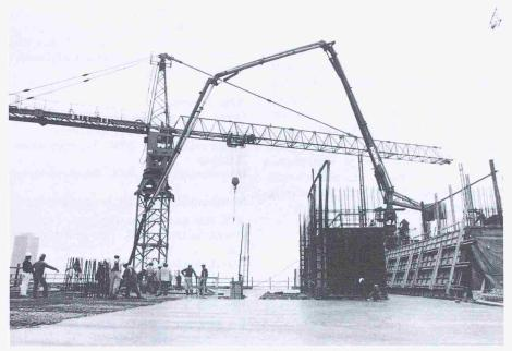
Ein separater Verteilermast mit 32 m Schwenkbereich schaffte es, den von einer einzigen Pumpe des selben Herstellers geförderten Beton über eine Fläche von 3250 m² einzubauen und alle fünf Tage ein Geschoss fertigzustellen (Werkbilder: Schwing)
