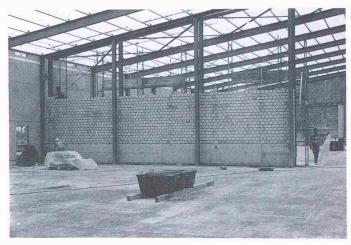
Bild 12. Brandmauer in der Papierfabrik, Regensdorf, in der Ausführung
