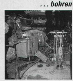
Der Abbruch von Betonteilen mit extrem grossen Ausmassen wird aus wirtschaftlichen Gründen durch Perforationsbohrungen oder mit hydraulischen Sprenggeräten ausgeführt.
