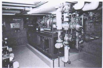
Bild 3. Zur Wärmeerzeugung des Werkhofes wurde eine Wärmepumpenanlage eingebaut. Genutzt wird die Abwasserwärme der angrenzenden Kläranlage Wattwil (Bilder 3 und 4: E. Baumann, Bazenheid)
