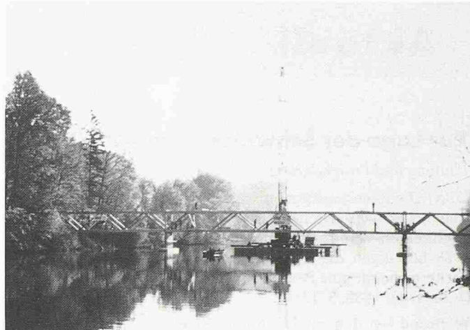
800 m flussabwärts reisten die drei Holzbrückenelemente auf der Reuss, bevor sie auf die Widerlager gesetzt wurden
