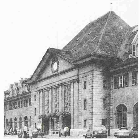
Bild 13. Das Aufnahmegebäude der SBB ist der wichtigste Bau des Quartiers. Sein Eingangsportal schliesst die Bahnhofstrasse ab und bildet Ausgangs- und Endpunkt der Achse zum Schloss
