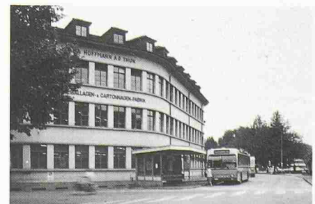
Bild 17. Kartonagefabrik der Fa. Hoffmann AG. Dieser Gebäudekomplex bildet das grösste Volumen im Quartier
