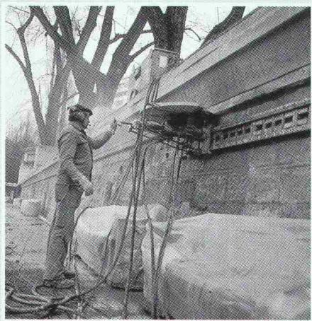
Die aufliegende Betonkonstruktion muss abgebrochen werden. Um das als Auflage dienende, unter Heimat- und Naturschutz stehende Sandsteinmauerwerk nicht zu beschädigen, wird mit einer Diamantkreissäge horizontal ein Trennschnitt erstellt.
