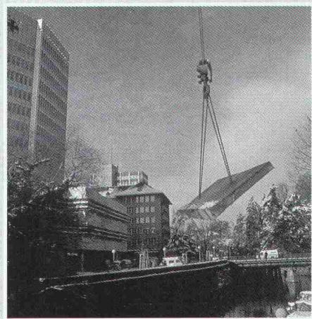
Die aufliegende Betonkonstruktion muss abgebrochen werden. Um das als Auflage dienende, unter Heimat- und Naturschutz stehende Sandsteinmauerwerk nicht zu beschädigen, wird mit einer Diamantkreissäge horizontal ein Trennschnitt erstellt.
