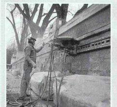
Die aufliegende Betonkonstruktion muss abgebrochen werden. Um das als Auflage dienende, unter Heimat- und Naturschutz stehende Sandsteinmauerwerk nicht zu beschädigen, wird mit einer Diamantkreissäge horizontal ein Trennschnitt erstellt.
