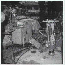
Der Abbruch von Betonteilen mit extrem grossen Ausmassen wird aus wirtschaftlichen Gründen durch Perforationsbohrungen oder mit hydraulischen Sprenggeräten
