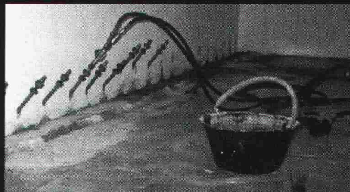
Elastische Abdichtungs-Injektion-Rascoflex in einer Zivilschutzanlage.
