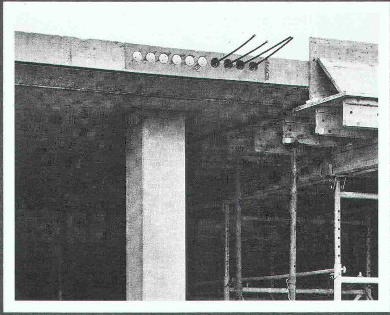
Decken mit StahlTon Stützstreifen-Vorspannung erfüllen alle diese Bedingungen mit Leichtigkeit. Vorfabrizierte Stützen aus hochfestem Beton können extrem schlank ausgebildet werden. Querschnitt, Oberfläche und Anschlussdetails richten sich nach Ihren Wünschen und Anforderungen. Und der richtige Ansprechpartner für Stützen und Vorspannung heisst in jedem Fall StahlTon; ein Bauprofi mit jahrzehntelanger Erfahrung.
