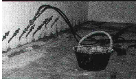
Elastische Abdichtungs-Injektion-Rascoflex in einer Zivilschutzanlage.
