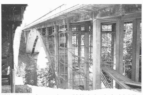
Bild 3. Die mit Spritzbeton instandgesetzte Echelsbacher Bogenbrücke erhält als Oberflächenschutz eine Beschichtung (7000 m²) mit zementgebundener Dichtungsschlämme (Weiss)
