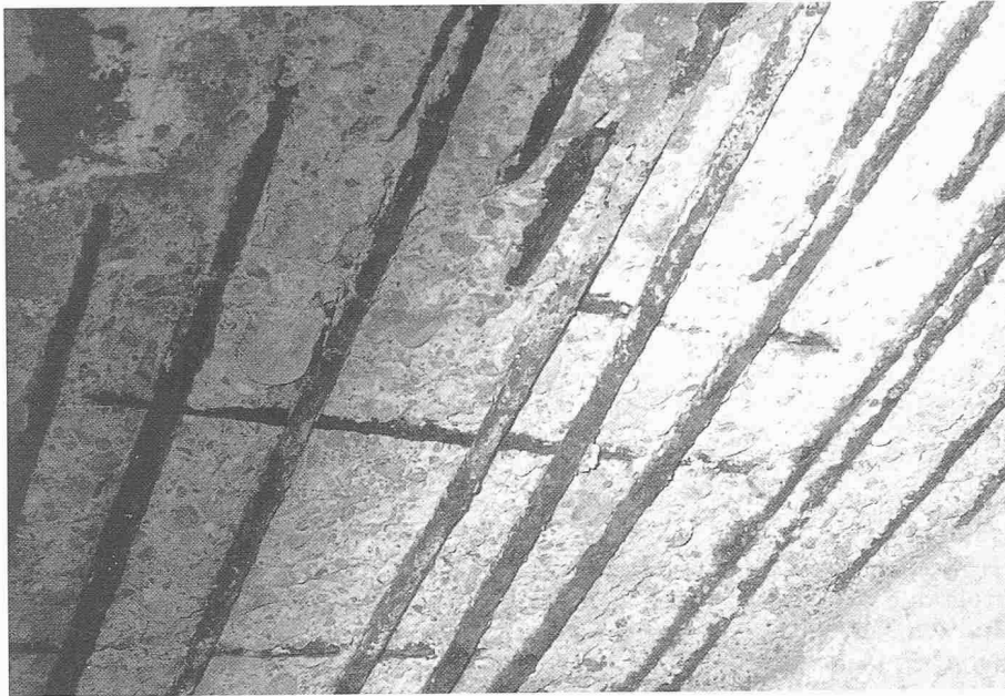
Bild 1. Korrodierte Bewehrungsstähle haben die Betonüberdeckung abgesprengt
