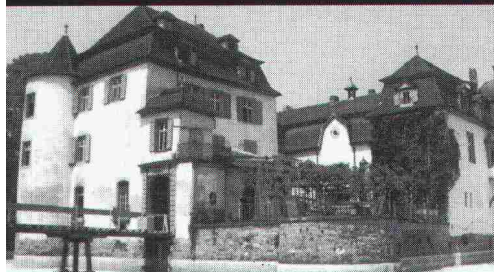
Rascolit-Flächenabdichtung und Horizontalsperre gegen aufsteigende Feuchtigkeit (Weierhenschloss Bottmingen).
