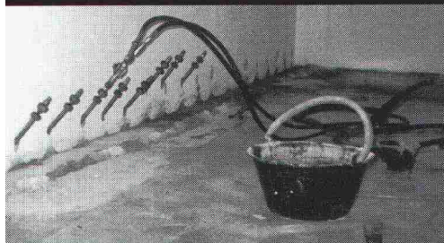
Elastische Abdichtungs-Injektion-Rascoflex in einer Zivilschutzanlage.
