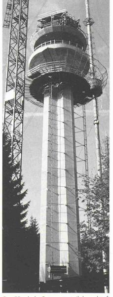
Der 55 m hohe Betonunterteil des zukünftigen, insgesamt 185 hohen Antennenturms auf dem Üetliberg ist fertiggestellt (Bild: Brunners Erben)
