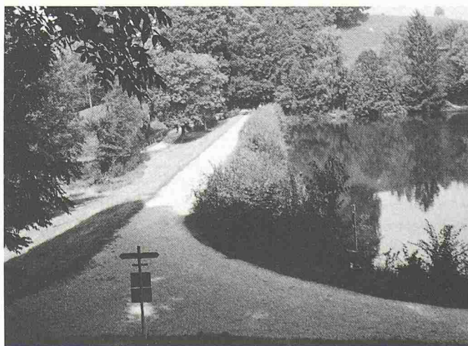
Im Norden und im Westen wird der Gübsensee von Dämmen abgeschlossen. Um die Standfestigkeit und Dichtigkeit zu gewährleisten, mussten die inzwischen grossgewachsenen Bäume entfernt werden. In der Mitte der Dämme (unter dem Weg) wurde eine 2,5 m tiefe Beton-Trennwand eingelassen, um die Dämme abzudichten (im Bild: der Westdamm)
