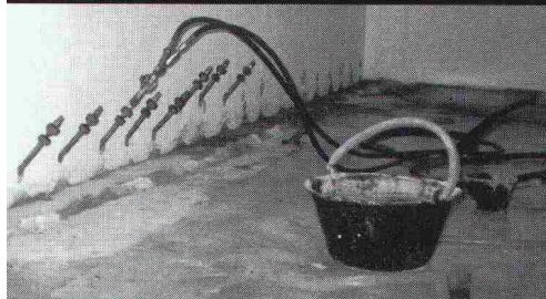
Elastische Abdichtungs-Injektion-Rascoflex in einer Zivilschutzanlage.
