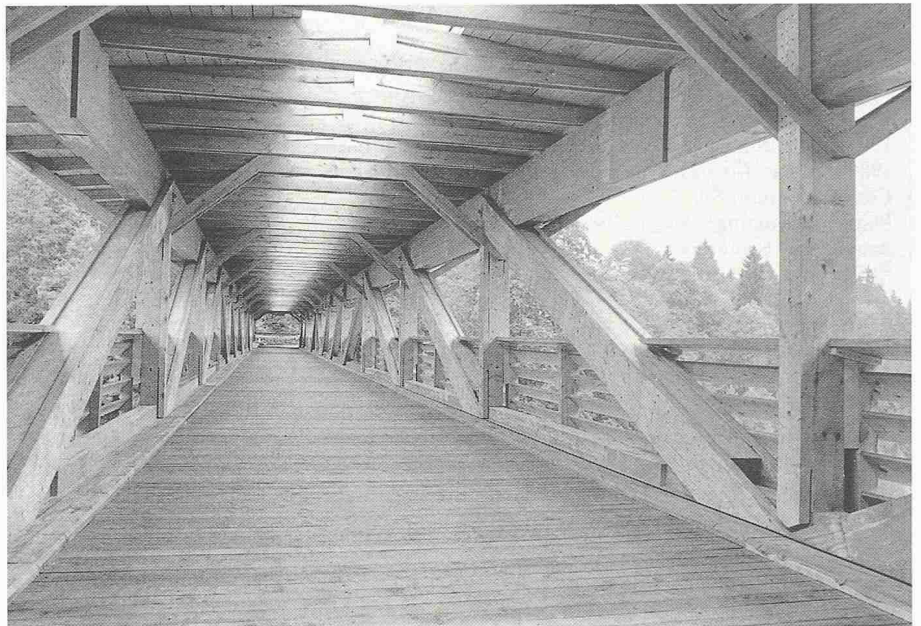
Bild 8. Ausdrucksstarke Brückenästhetik – im erhellten Inneren durch das einfallende Licht aus dem Acryl-Lichtband und von den Seiten her durch transparentes Brüstungsgeländer
