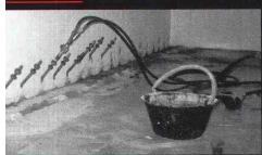
Elastische Abdichtungs-Injektion-Rascoflex in einer Zivilschutzanlage.
