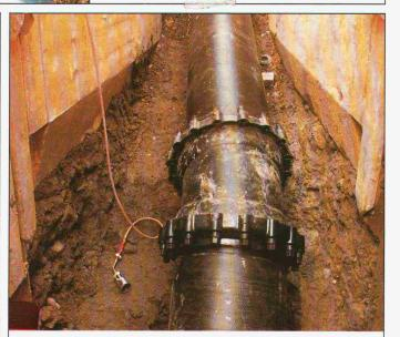
ufgrund der instabilen Bodenverhältnisse und der Druckverhältnisse musste die Leitung schubgesichert werden. Hier bewährten sich die Schubsicherungssysteme TIS (Bild) und TIS-K für hohe Betriebsdrücke. Ihr Vorteil liegt bei der kugelgelenkartigen Konstruktion, die gewährleistet, dass die Zugkräfte auch bei einer Muffenauslenkung von 3 Grad auf den vollen Rohrumfang (= 360 Grad) wirken. Gefährliche Punktlastlagen können nicht auftreten.
