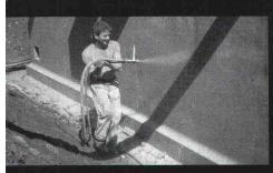
Starre Rascolit-Abdichtung an einer Tiefgarage gegen Grund- und Meteorwasser.
