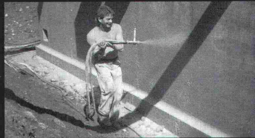
Starre Rascolit-Abdichtung an einer Tiefgarage gegen Grund- und Meteorwasser.
