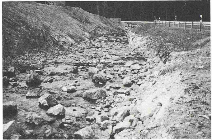
Bild 6. In naturgemässer Röhnenbauweise gestalteter Bachlauf
