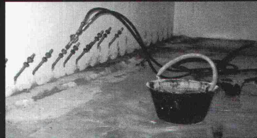
Elastische Abdichtungs-Injektion-Rascorflex in einer Zivilschutzanlage.
