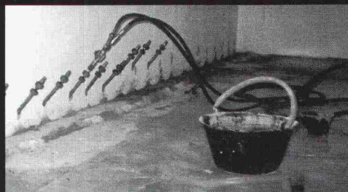
Elastische Abdichtungs-In- jektion-Rascoflex in einer Zivilschutzanlage.
