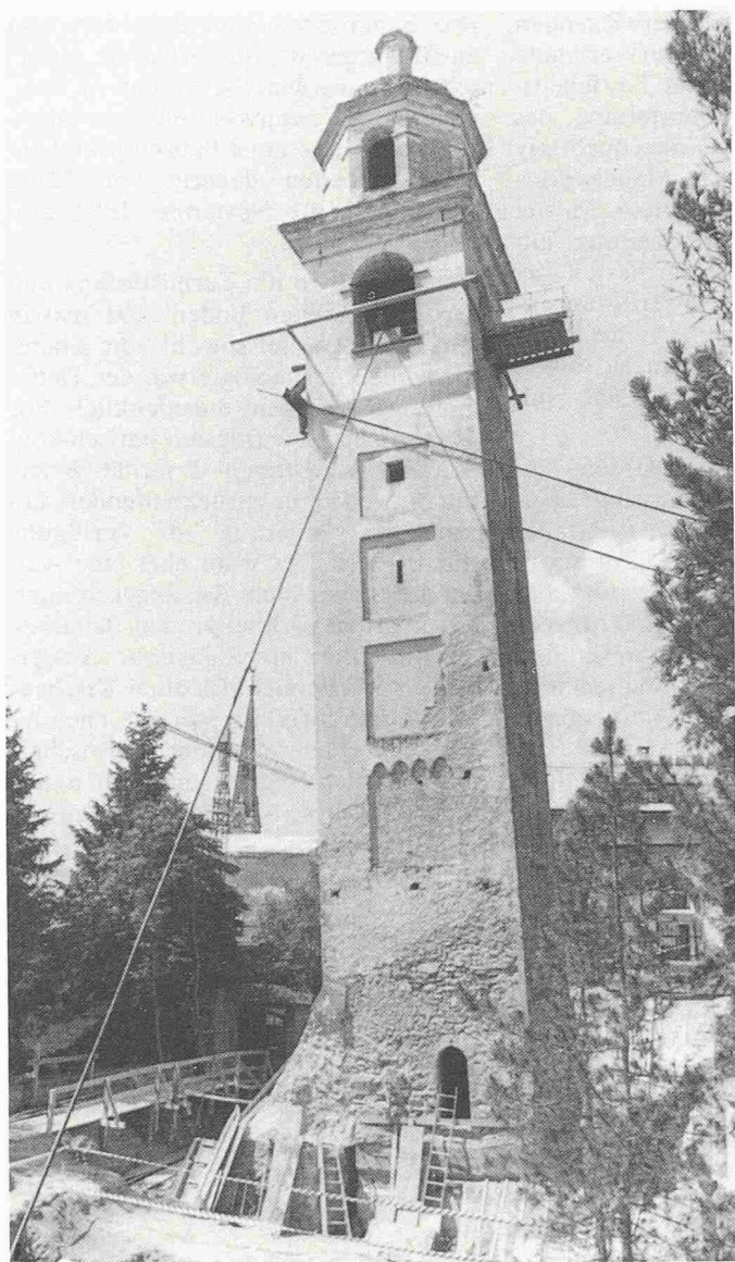
Bild 8. Detailansicht des Fundamentsockels aus dem Jahre 1928 und des bestehenden Turmmauerwerks vor Erstellung des neuen Turmkragens. Querverspannung des Turmfusses. Lot (links) zur Kontrolle der Turmbewegungen während der Bauzeit (Foto E. Brügger, Zürich)
