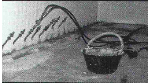
Elastische Abdichtungs-Injektion-Rascoflex in einer Zivilschutzanlage.
