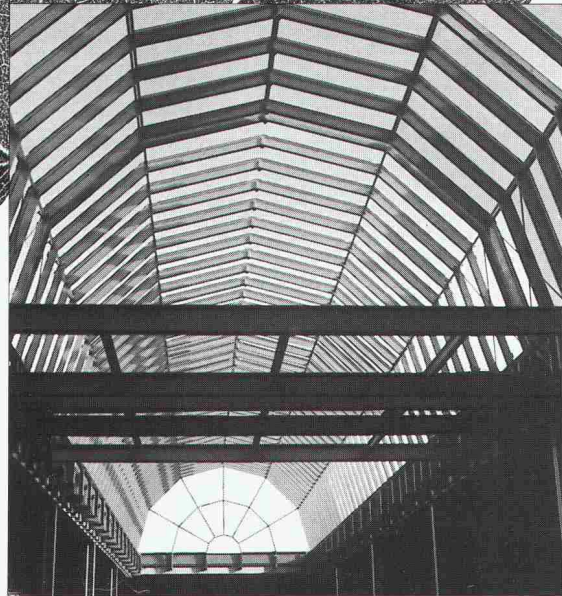
Stahl- und Industriebau
