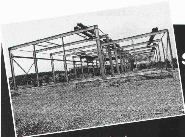
**Stahlbauten schützt man durch Feuerverzinken vor Korrosion. Jahrzehntelang und wortungsfrei.**
