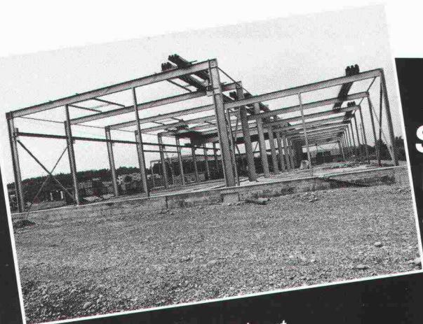
**Stahlbauten schützt man durch Feuerverzinken vor Korrosion. Jahrzehntelang und wortungsfrei.**
