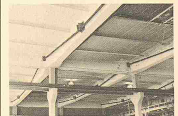
Bild 3. Seitlich neben den Trägern eingebaute Spannkabel in der Fabrikationshalle der Maschinenfabrik Schulthess
