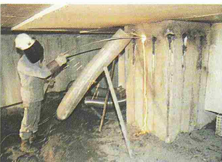
Bild 15. Abschmelzen der Druckzone im Pfeiler (L. Buscarlet)
