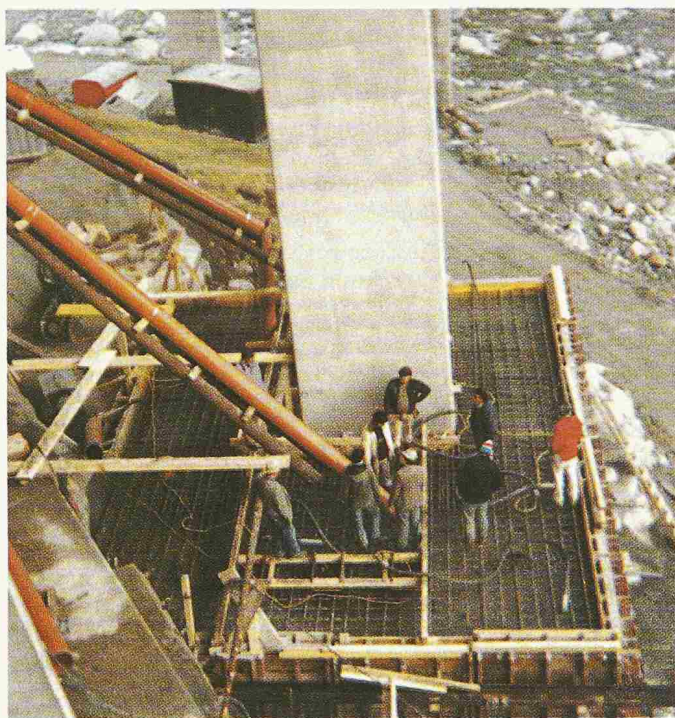
Bild 6. Betonieren neues Fundament R. Kalbermatten
