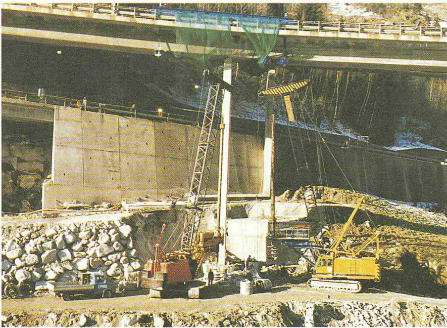
Bild 5. 2 Bohrgeräte beim Pfählen (A. von Glutz)
