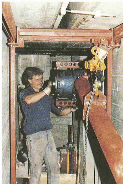
Bild 16. Vorspannung Überbau, Spannen der Kabel bei den Widerlagern
