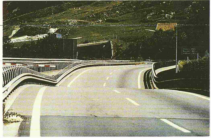
Bild 3. Verformter Brückenträger (Bildautor: T.R. Schneider)
