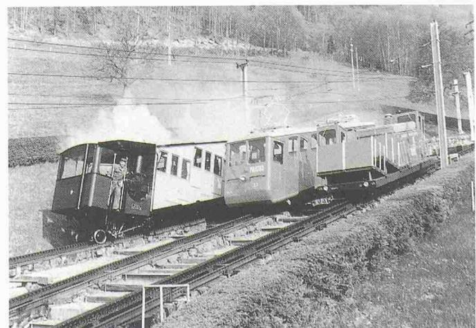
Drei Generationen der steilsten Zahnradbahn der Welt: links ein Dampftriebwagen von 1889, in der Mitte ein elektrischer Triebwagen von 1937 und rechts ein dieselelektrischer Gütertriebwagen 1982
