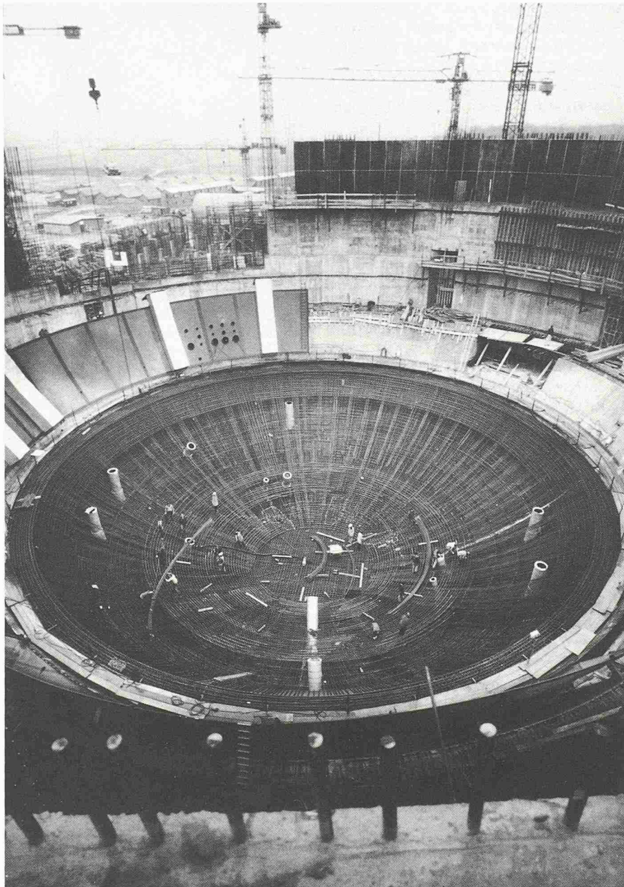
Bild 2. Bau des Containments für das KKW Gösgen, Stand Januar 1975
