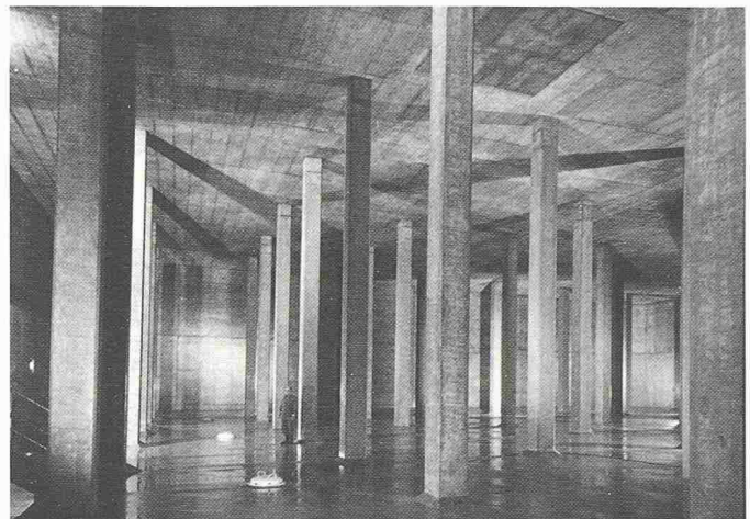
Bild 8. Trinkwasser-Reservoir mit unverputzten Wänden
