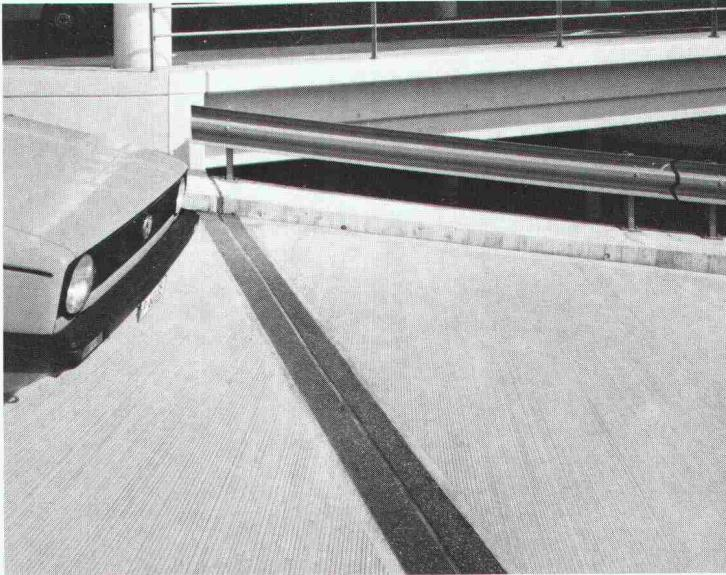
**Der Avenit-Fugenübergang** macht die Dilatationsfuge im Hoch- und Tiefbau erst perfekt: Wasser- und schmutzdicht, resistent gegen Chemikalien, verschleissfeste, griffige Oberfläche. Auch nachträglich eingebaut, passt er sich jeder Belagsstärke, allen baulichen Eigenarten und der nötigen Bewegungsgröße an.
