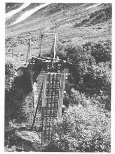
Steffenbachbrücke: Das talseitige Segment mit dem abgeklappten Mittelteil ist ausgezogen und kann auf das Widerlager abgesenkt werden
