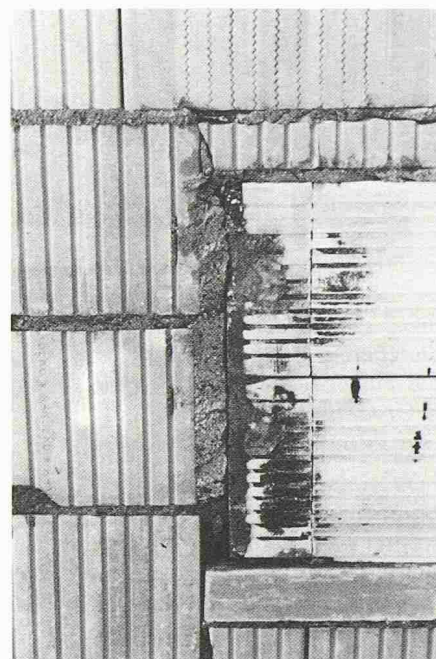
Bild 1. Zwei Praxisbeispiele, wie Fensterstürze versetzt werden. Der Mauermörtel hat sich bereits vom Sturzelement abgelöst
