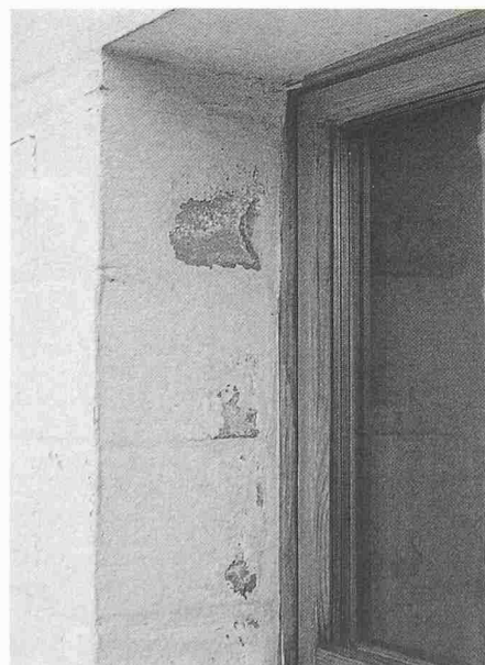
Bild 9. Anstrichablösungen und Ausblühungen auf einem Kalksandsteinmauerwerk
